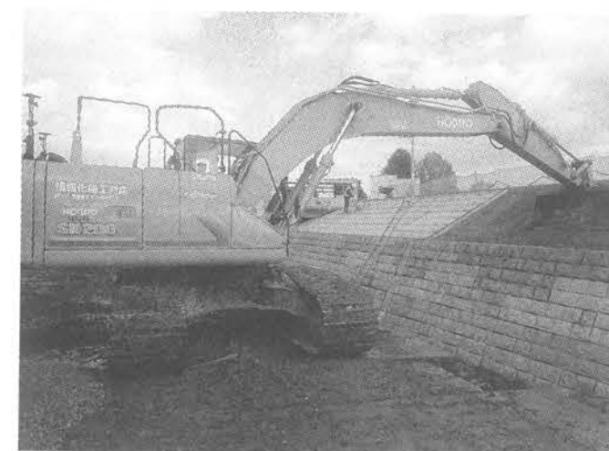
MGバックホウによる整形作業
