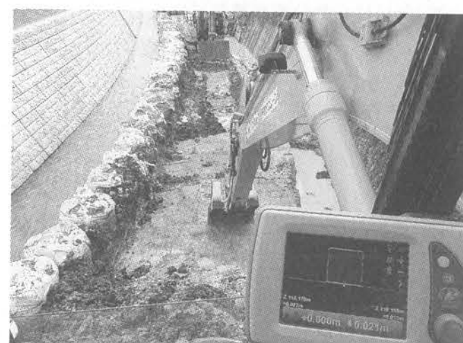
床掘り作業においてMGバックホウが活躍
